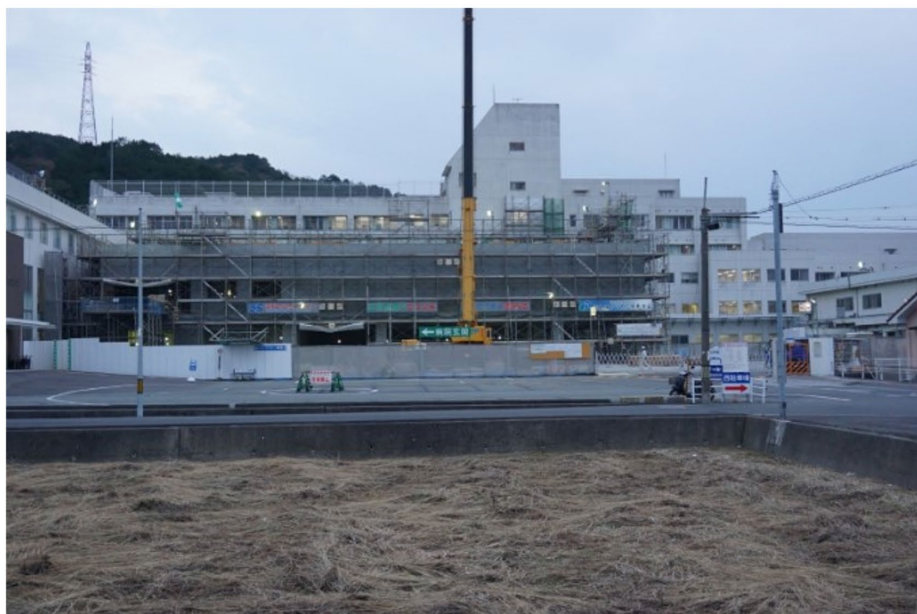
躯体・内装工事状況
