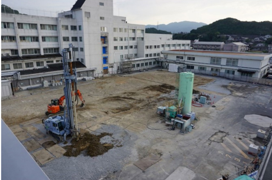
基礎下 地盤改良杭施工状況
