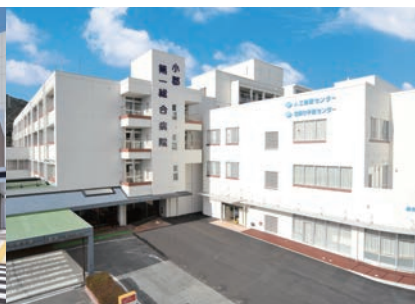
小郡第一総合病院
