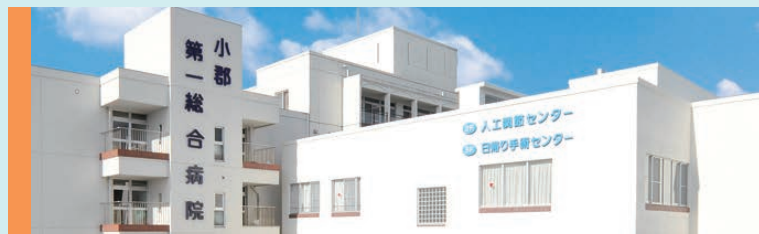
15-18 小郡第一総合病院
