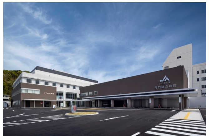
(令和 3 年 7 月に竣工した本館病棟)
