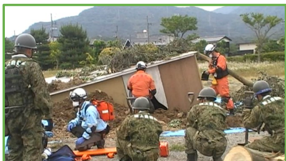
倒壊家屋から救出する様子
